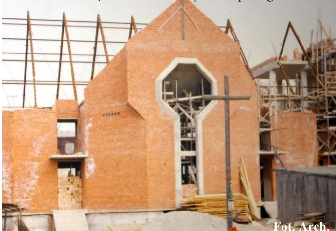
Widok na budowę kościoła od strony ul. Niepodległości
